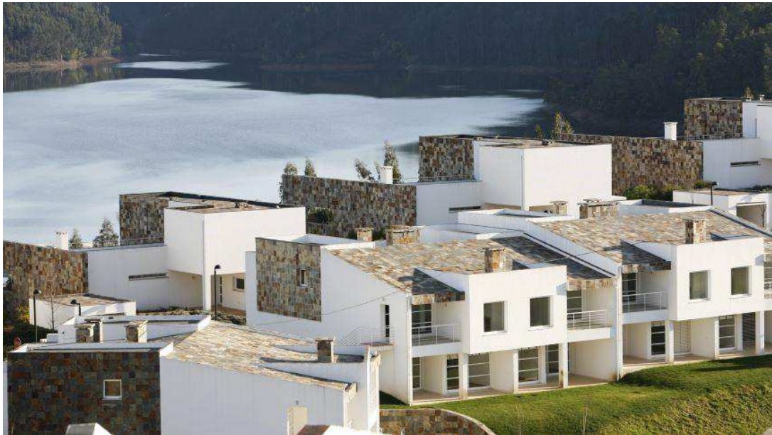
Exterior Montebelo Aguieira
