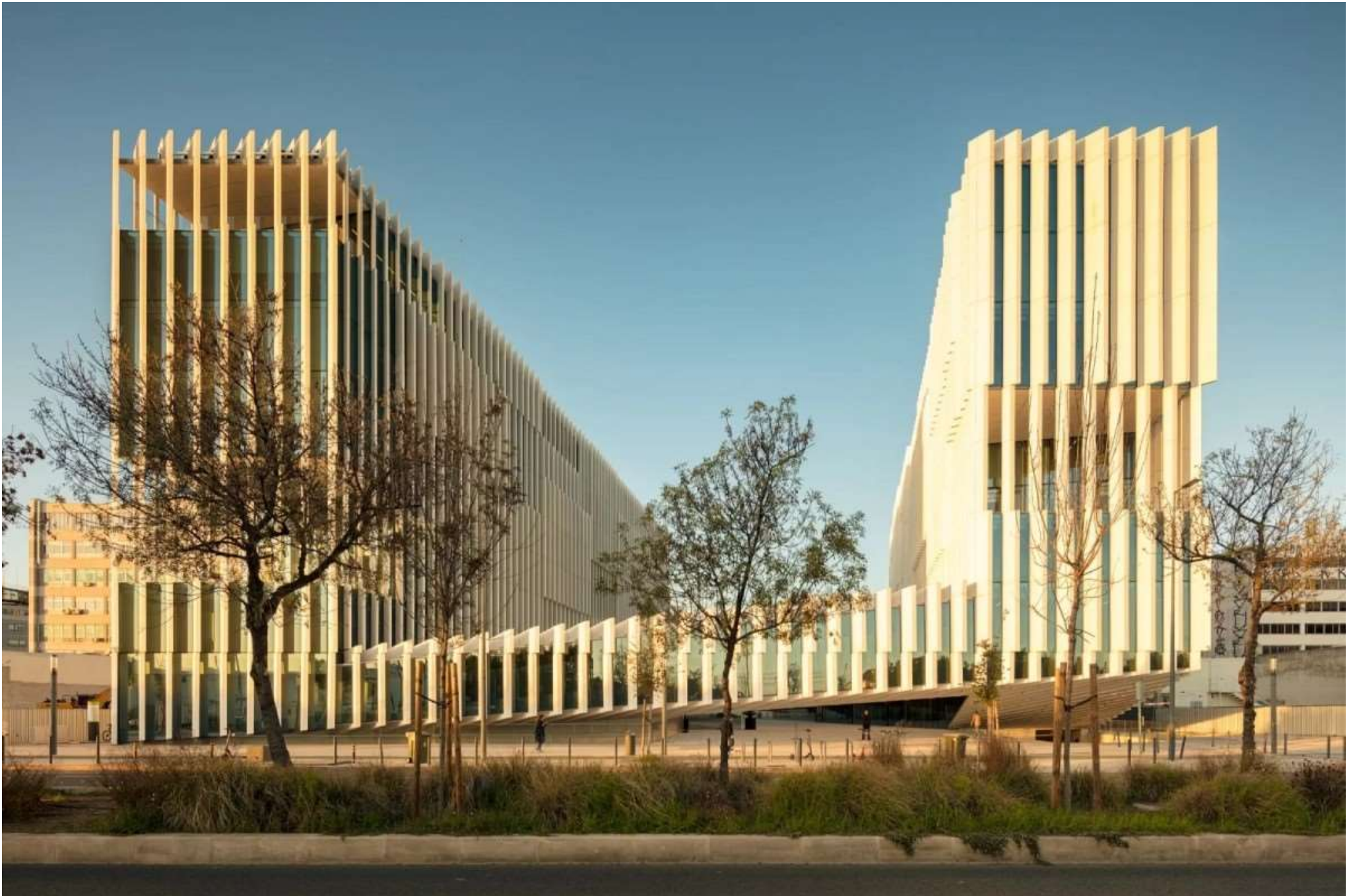
Sede da EDP, em Lisboa, foi construída pela HCI Construções / Créditos: HCI Construções
